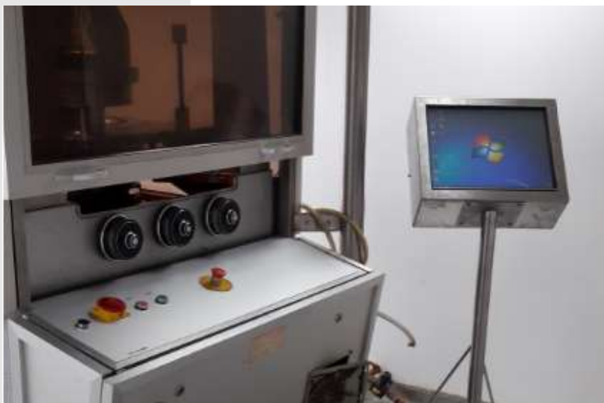
Panneau de commande après un rétrofit 4.0
